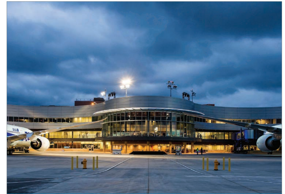
El 'Boeing Delivery Center' en Everett, Washington (EE.UU.), recibió la certificación LEED Oro otorgada por el Green Building Council de los EE.UU. por su bajo consumo de energía y agua y el uso de materiales reciclables y obtenidos localmente. (Foto de Boeing)
