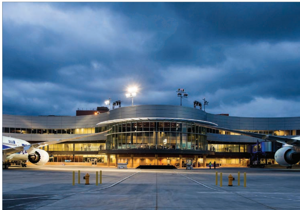
Il Boeing Delivery Center a Everett, nello stato di Washington, ha ricevuto la certificazione LEED Gold dal Green Building Council americano, per il suo ridotto consumo di acqua ed energia e l'utilizzo di materiali riciclati e locali. (Foto Boeing)
